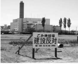
「建設反対」の看板が立つ吉見町大串地区。建物は保全組合のゴミ焼却場。
